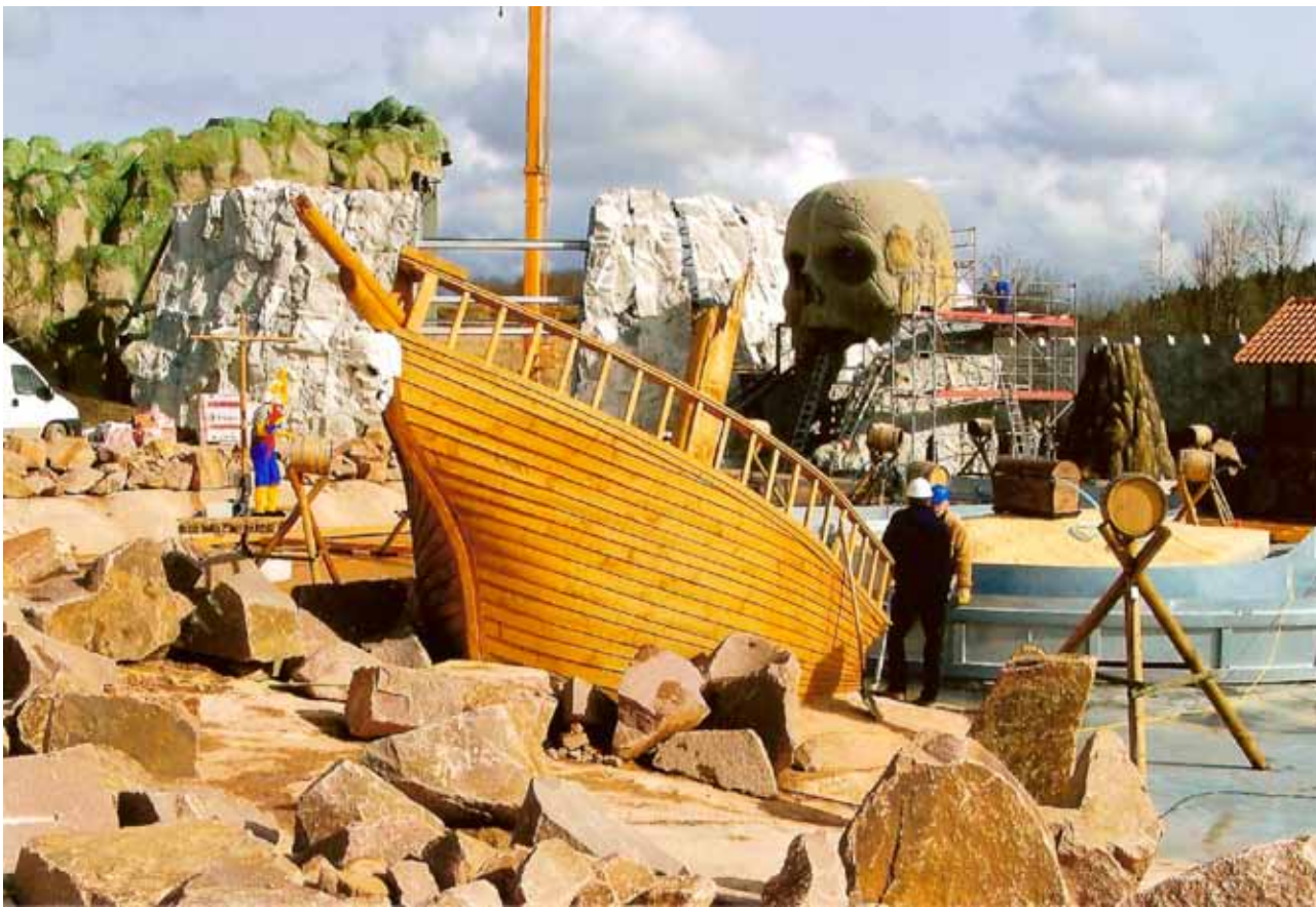
• Das Piratenschiff in einem Wasserspielplatz des Legolandes hat die Zimmerei Orner bereits 2008 gebaut. Die zwölf Millimeter dicken Bretter wurden ebenfalls mit dem LM40 geschnitten und für den Schiffsrumpf gebogen. Fotos: PRIVAT
