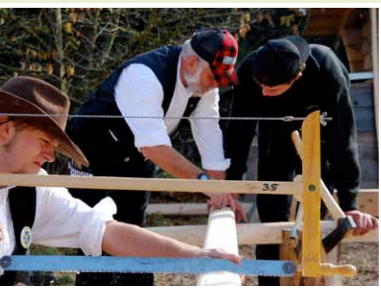
on und genaues Maßnehmen ist beim Blockhausbau unerlässlich.
